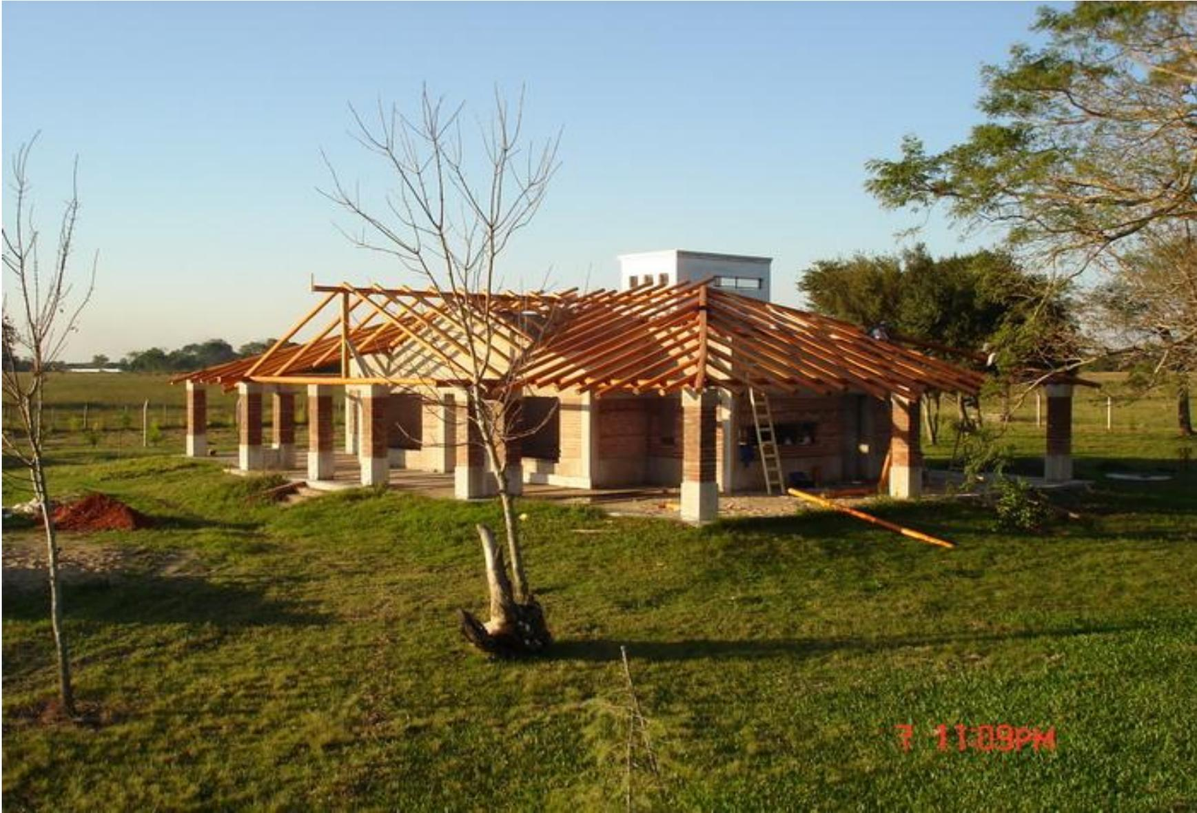
Techo con estructura de madera a la vista y cubierta de chapa
